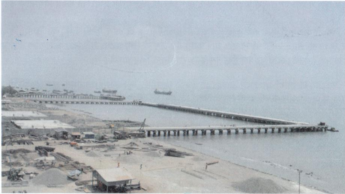
सिटवे में पत्तन का निर्माण और बैकअप की सुविधा
