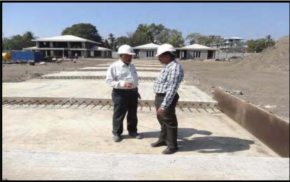
सितवे, म्यांमार में सड़क और सिविल कार्य निर्माणाधीन
