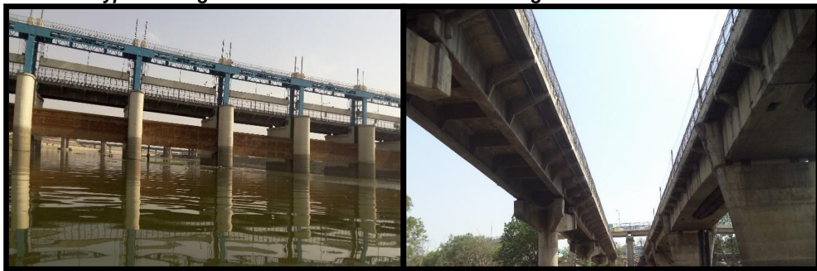
Gomti Barrage Ch 507.87 km
