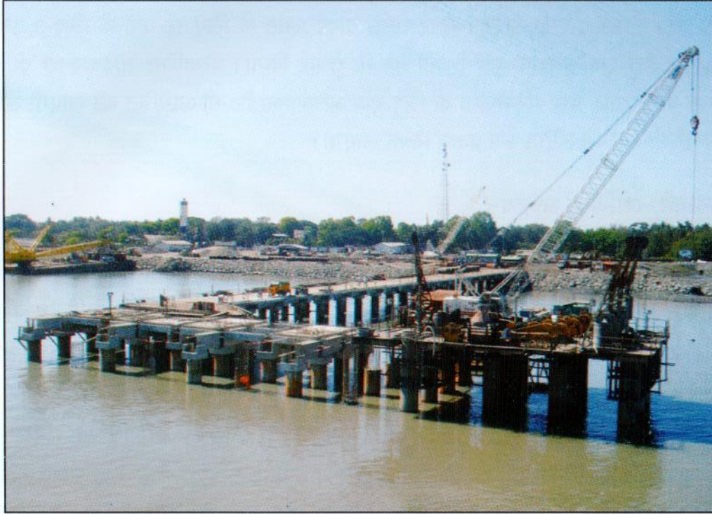
सिटवे में पत्तन और बैकअप सुविधाओं के निर्माण की प्रगति
