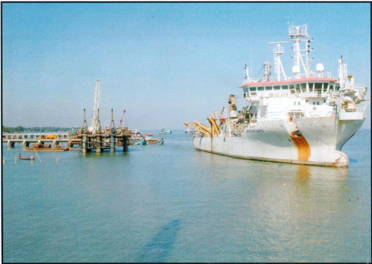
सितवे में आई.डब्ल्यू.टी. जेट्टी निर्माण और निकर्षण की प्रगति
