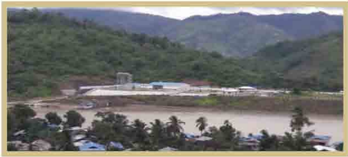
पलेतवा में अजय जेट्टी का निर्माण
