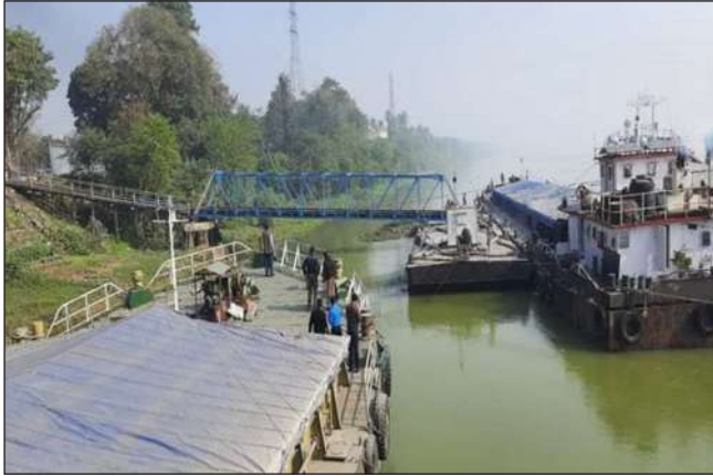
Bandel jetty on NW-1
