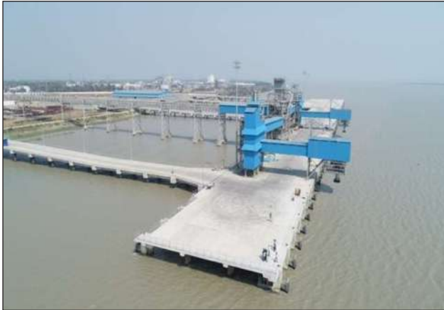
MMT Haldia under construction
