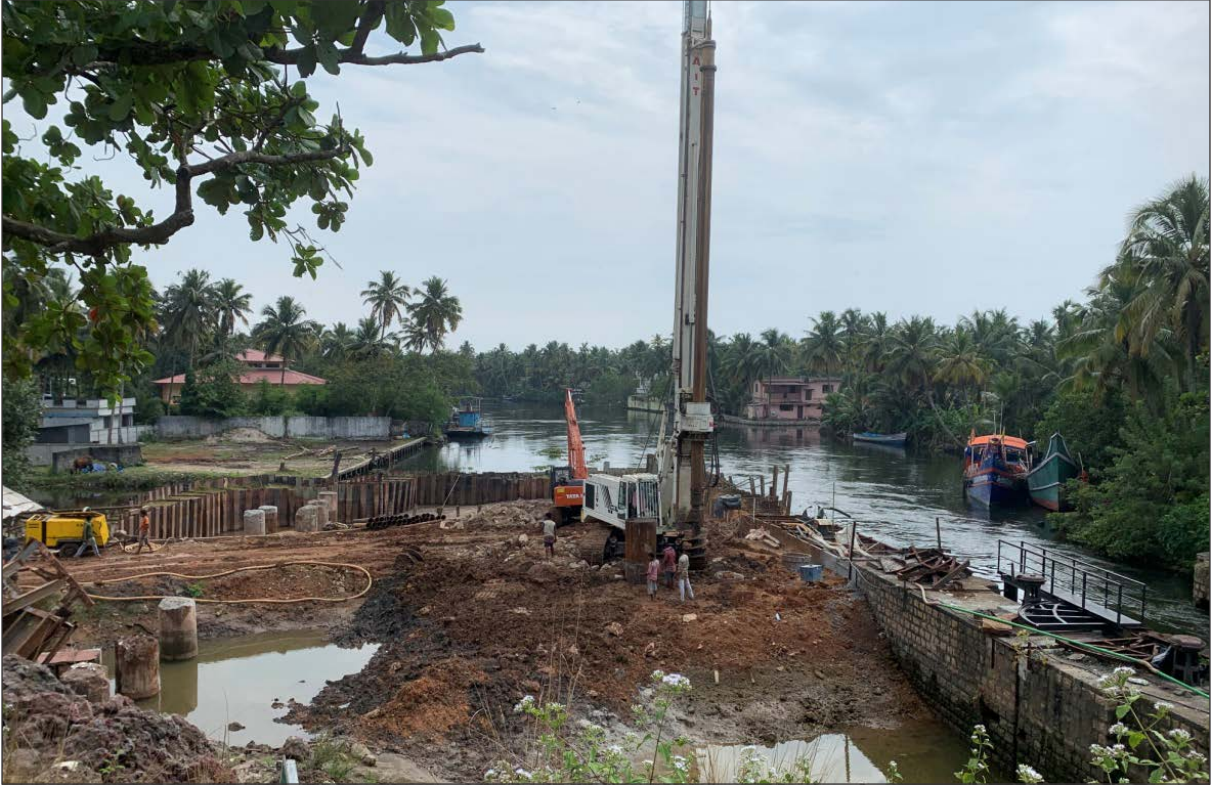
त्रिकुणापुझा में पाइलिंग कार्य – लॉक गेट का निर्माण कार्य प्रगति पर है।
